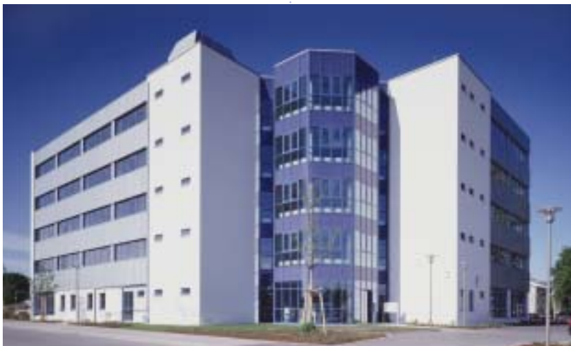
Das Firmengebäude der betapharm am Kobelweg in Augsburg. In der obersten Etage arbeitet das beta Institut.
